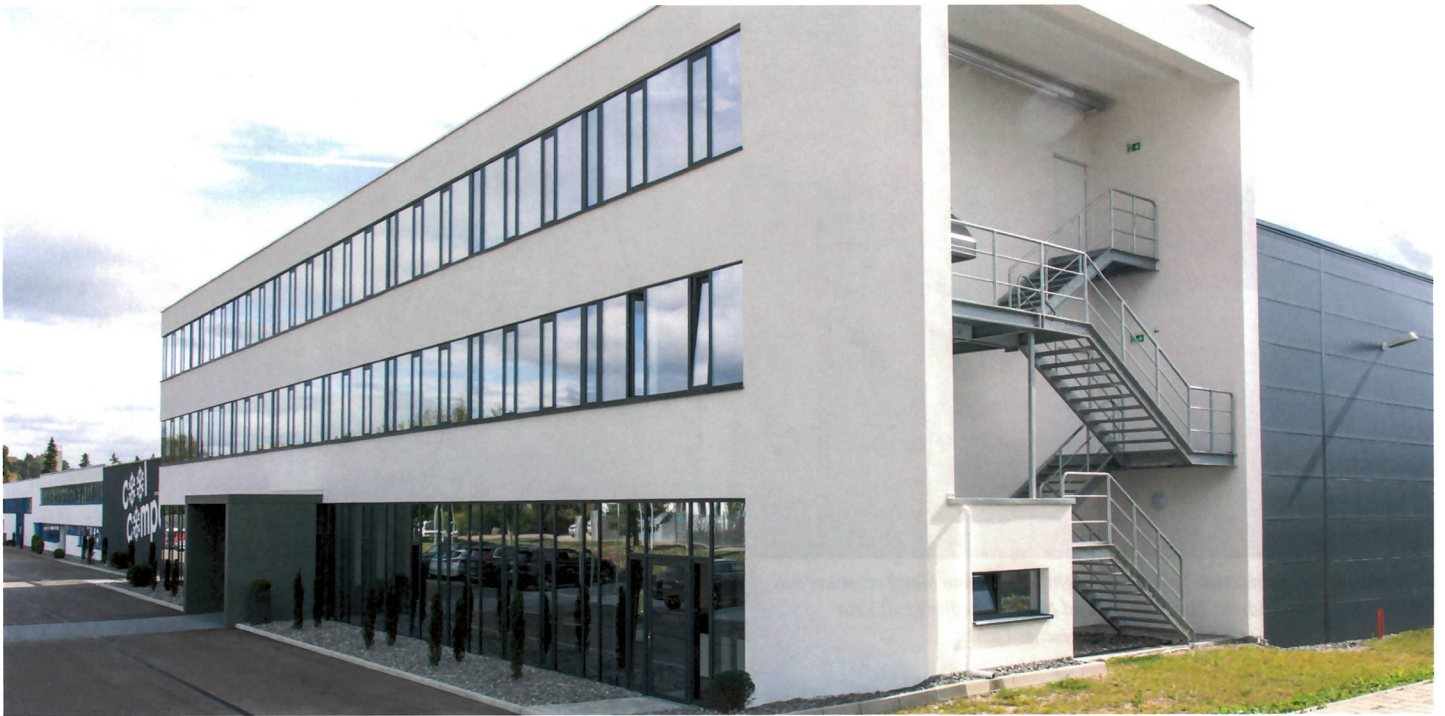
Mit dem Verwaltungsneubau und der neuen Lagerhalle investiert Cool Compact in die Zukunft und schließt die Baulücke auf dem Gelände in Grosselfingen.
